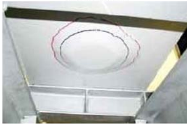
押抜試験状況
