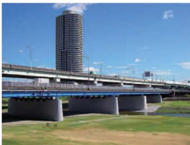
【河積阻害率の制約下での施工例】
