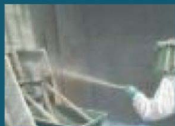
リフレドライショット工法での吹付け
