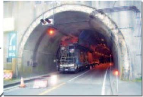
施工中(足場状況)
