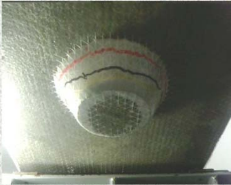
押し抜き試験状況
