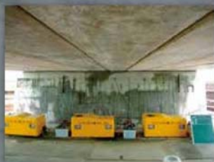
内部圧入工 (ASRリチウム工法)
