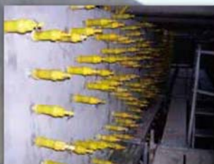
ひび割れ注入 (低圧注入工法)
