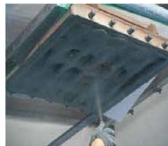
●鉄筋背面への充填性試験
