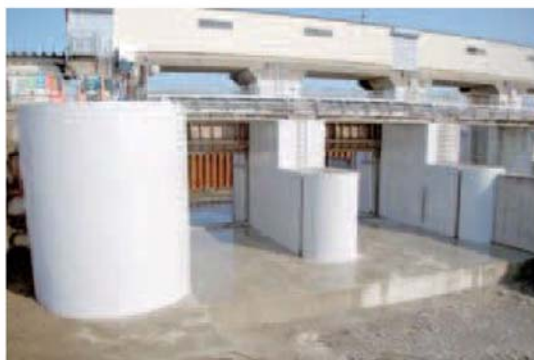
【水門の施工例】
